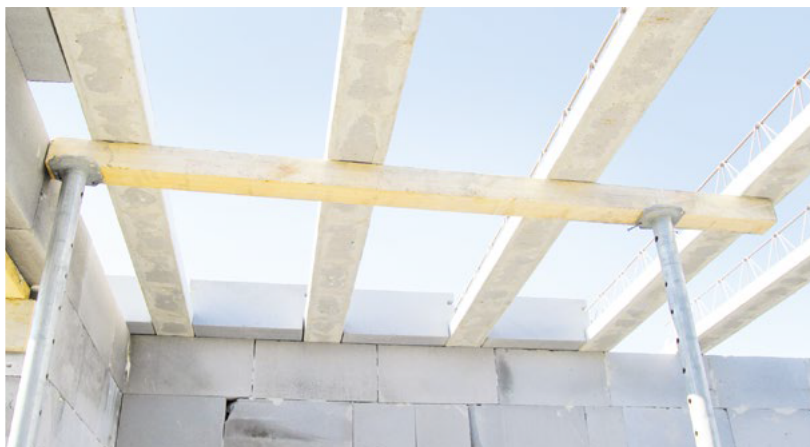
Podpěření stropních nosníků
