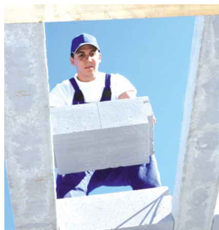
Ukládání stropních vložek
